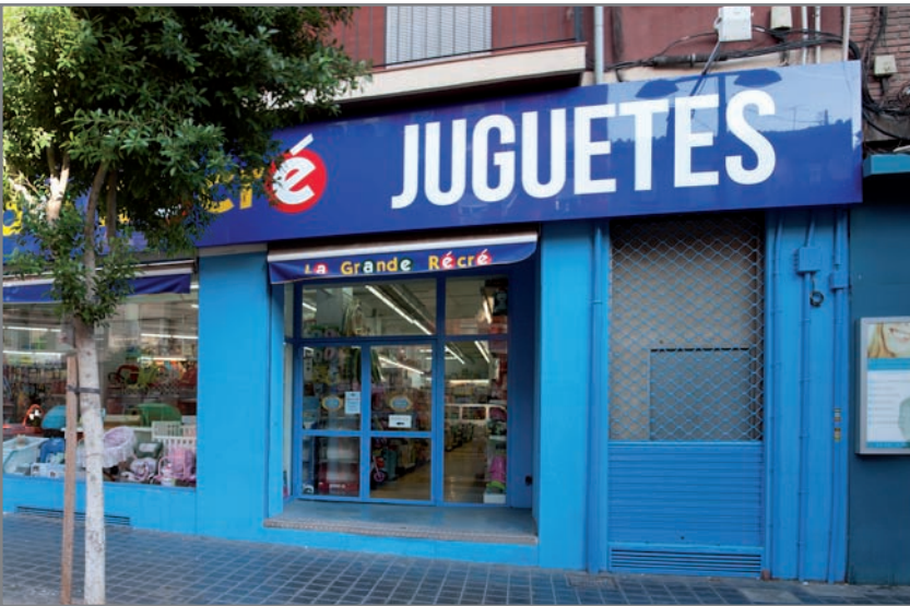
Local sotano en la Avenida peris y valero, esta todo el local de obra
